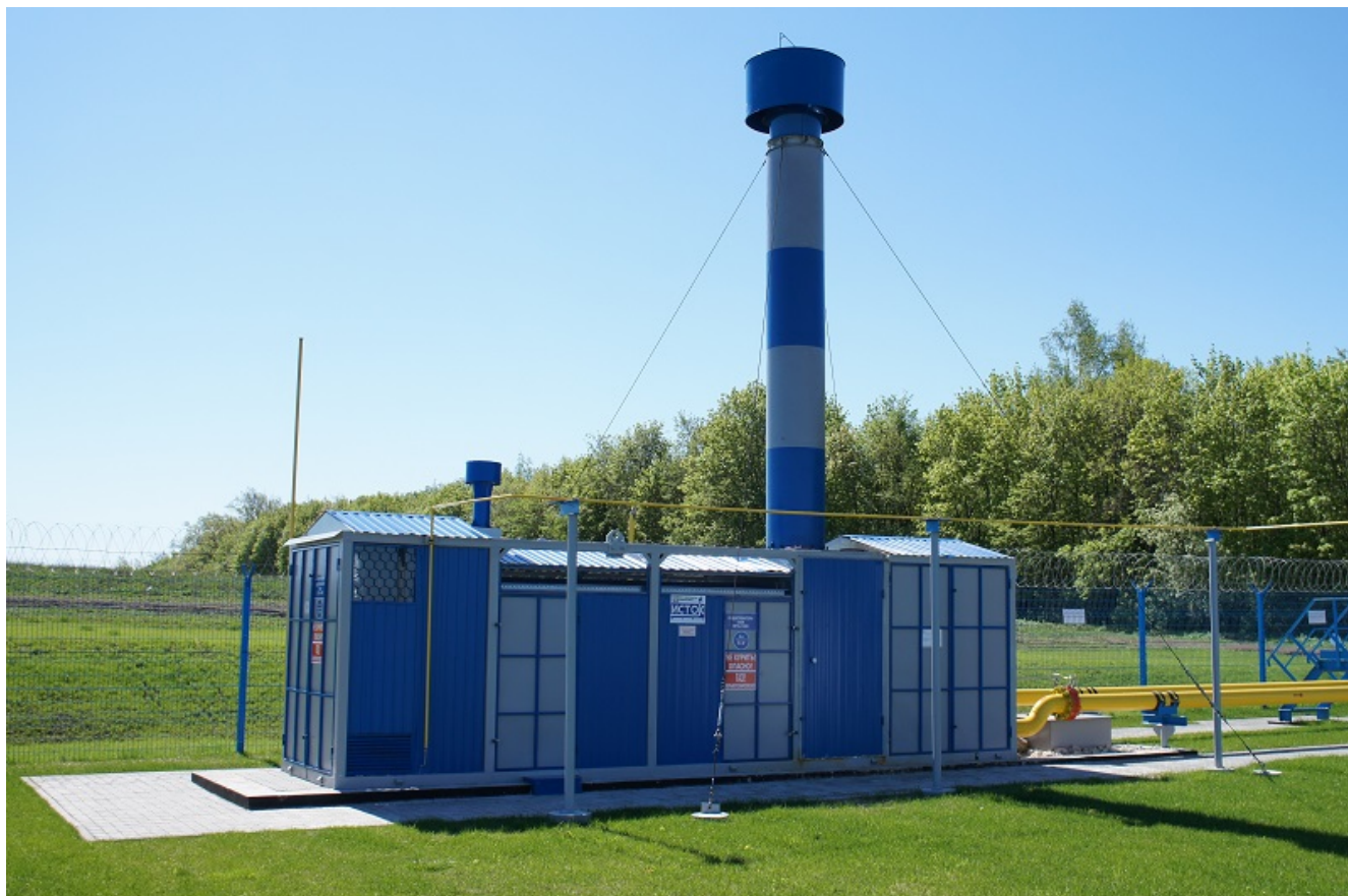
Рис.1. Подогреватель газа ПГТА-1600М
