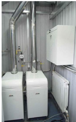
Рис 4. Узел подогрева газа
