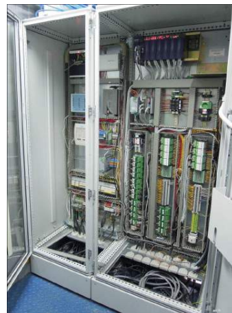
Рис 5. Система управления со шкафом вторичных приборов
