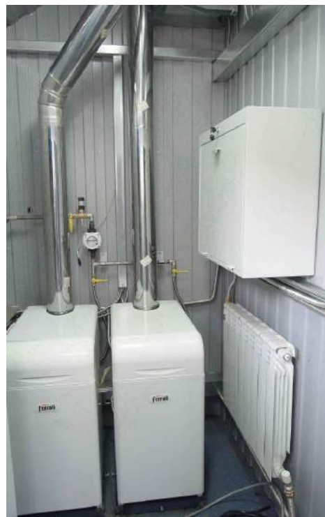
Рис 4. Узел подогрева газа
