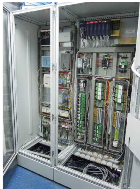
Рис 5. Система управления со шкафом вторичных приборов
